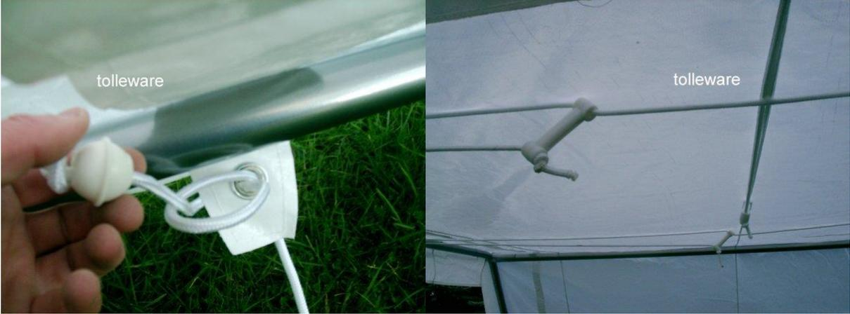
8. jetzt die zweite Längsseite aufstellen und das Dach mit den Gummilaschen sichern
