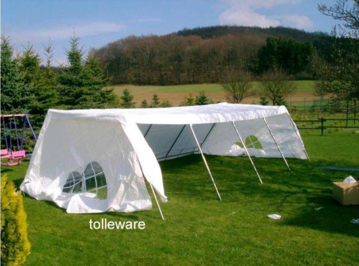
7. jetzt die Seile anbringen und das Dach somit befestigen
