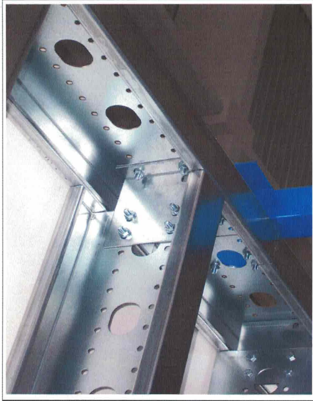
Montagebeispiel Hilfsträger/Hauptträger mit Winkelplatte
