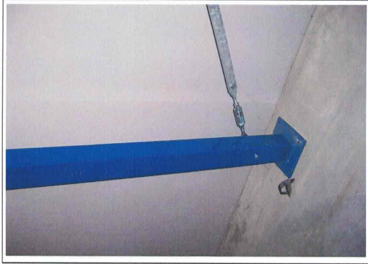
Montagebeispiel Stütze mit Kreuzverstrebung
